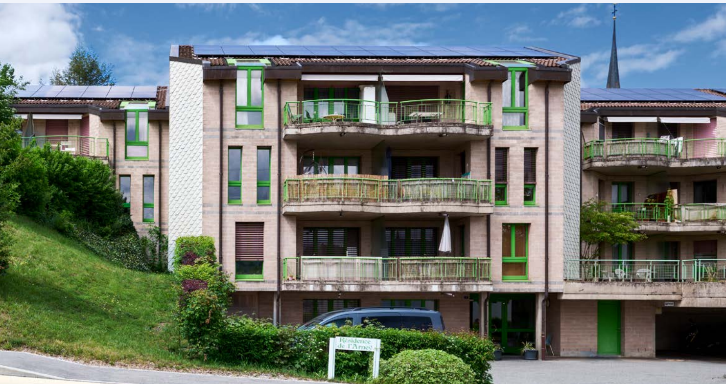
Das ganze Mehrfamilienhaus von Haus mit den neuinstallierten Photovoltaikanlagen auf den Dächern.
