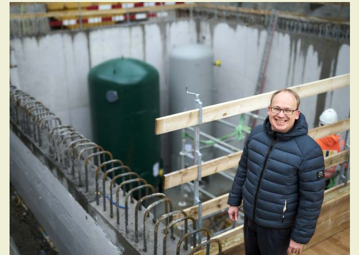
Thomas Schütz, Projektleiter von Energie 360° vor der laufenden Baustelle hinter der Schulthess Klinik.
