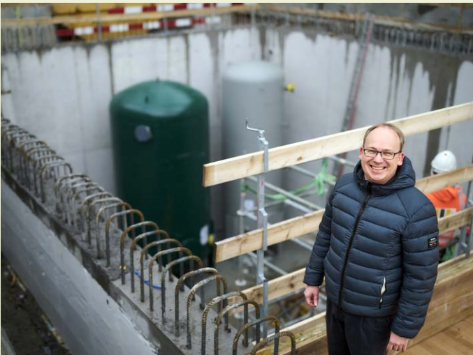
Thomas Schütz, chef de projet chez Energie 360°, devant le chantier en cours derrière la clinique Schulthess.
