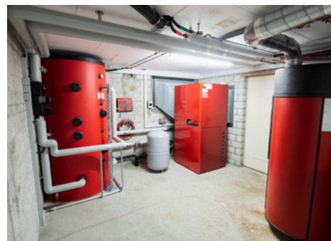
Ein Heizsystem mit erneuerbaren Energien reduziert den CO 2 -Ausstoss auf nahezu null.
