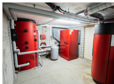
Un chauffage fonctionnant à partir d'énergies renouvelables réduit les émissions de CO 2 à un seuil proche de zéro.
