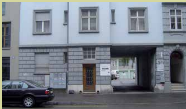
Un assainissement complet s'impose! (photo: © dürig architekten). Avant assainissement
