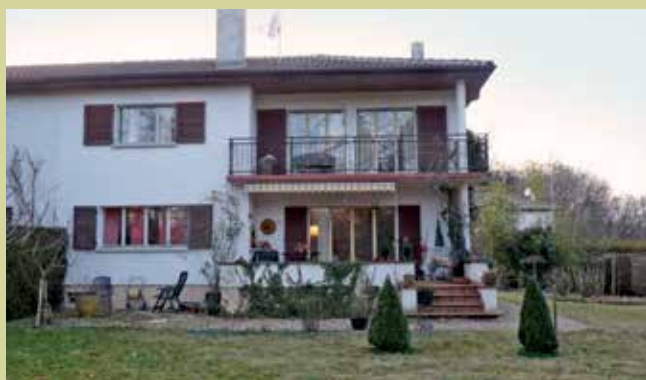
Côté jardin, à l'état ancien.
