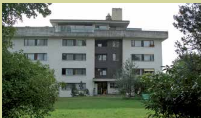
Le temps a fait son œuvre. Avant assainissement
