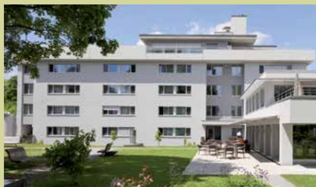
Une rénovation salubre. Après assainissement
