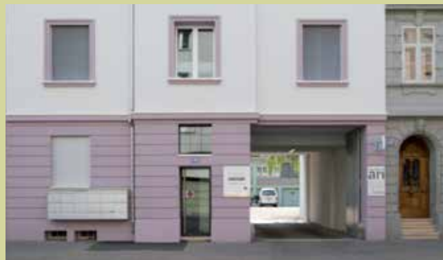
Désormais plus sobre en énergie qu'une construction neuve. Après assainissement
