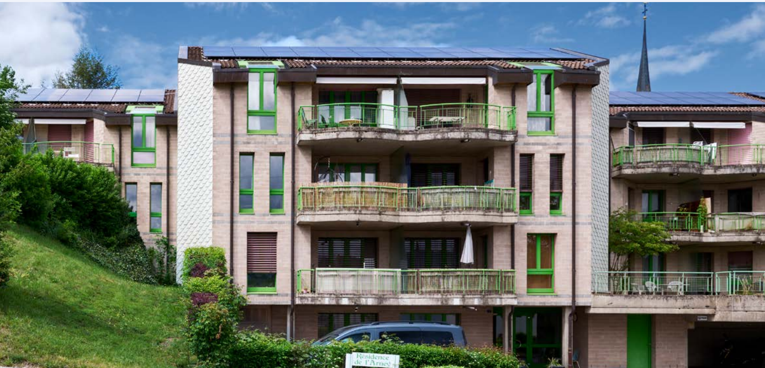
L'intera casa plurifamiliare con i nuovi impianti fotovoltaici installati sui tetti.
