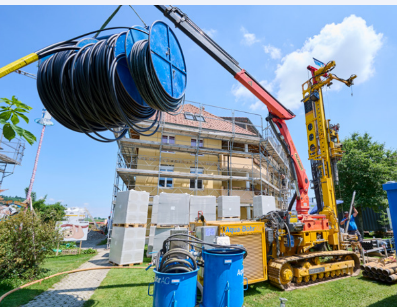
Les forages pour la pompe à chaleur (sonde géothermique) sont en cours. Elle remplacera le chauffage au mazout.
