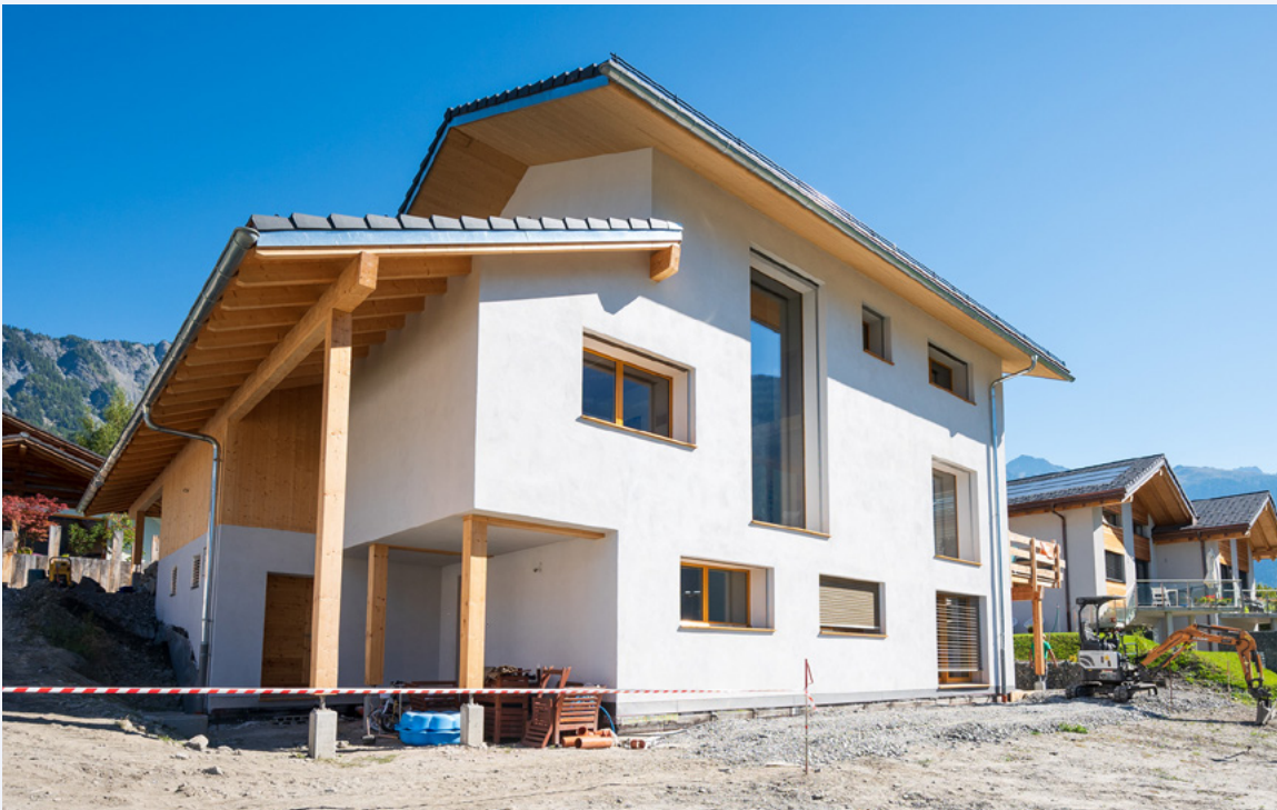
La nouvelle construction (CECB A/A) est à base de matériaux naturels qui contiennent quasiment aucune énergie grise.
