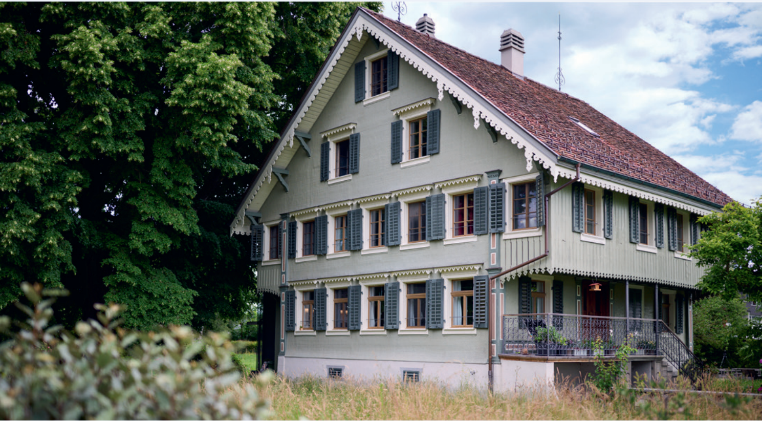
Più di 300 anni e bella come mai prima: la casa dopo la ristrutturazione.
